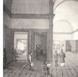
Quartos de malta da Antiga Cadeia e Tribunal da Relação do Porto. Localizam-se no último piso do edifício e destinavam-se a prisões individuais para «pessoas de condição».
