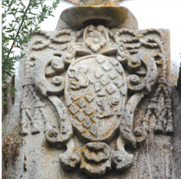
Capela da Granja Velha – En su fachada destaca la piedra de armas del fundador: el presbítero Lourenço Valadares Vieira.
