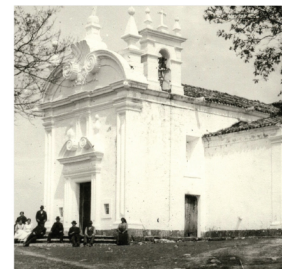
Capela de Nossa Senhora da Guia – Fue construida, en la primera mitad del siglo XVIII, por devoción y voto de los señores de la Casa de Santa Marinha y Casa do Mato. Corona la fachada una gran concha (vieira) en granito. No es difícil relacionarla con la influencia de Santiago de Compostela.
