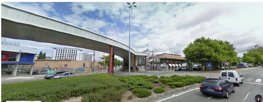
Figura 20: Viaduto de ligação à Av. Fabril do Norte - Amplas superfícies sem utilização e déficit de enquadramento paisagístico.
